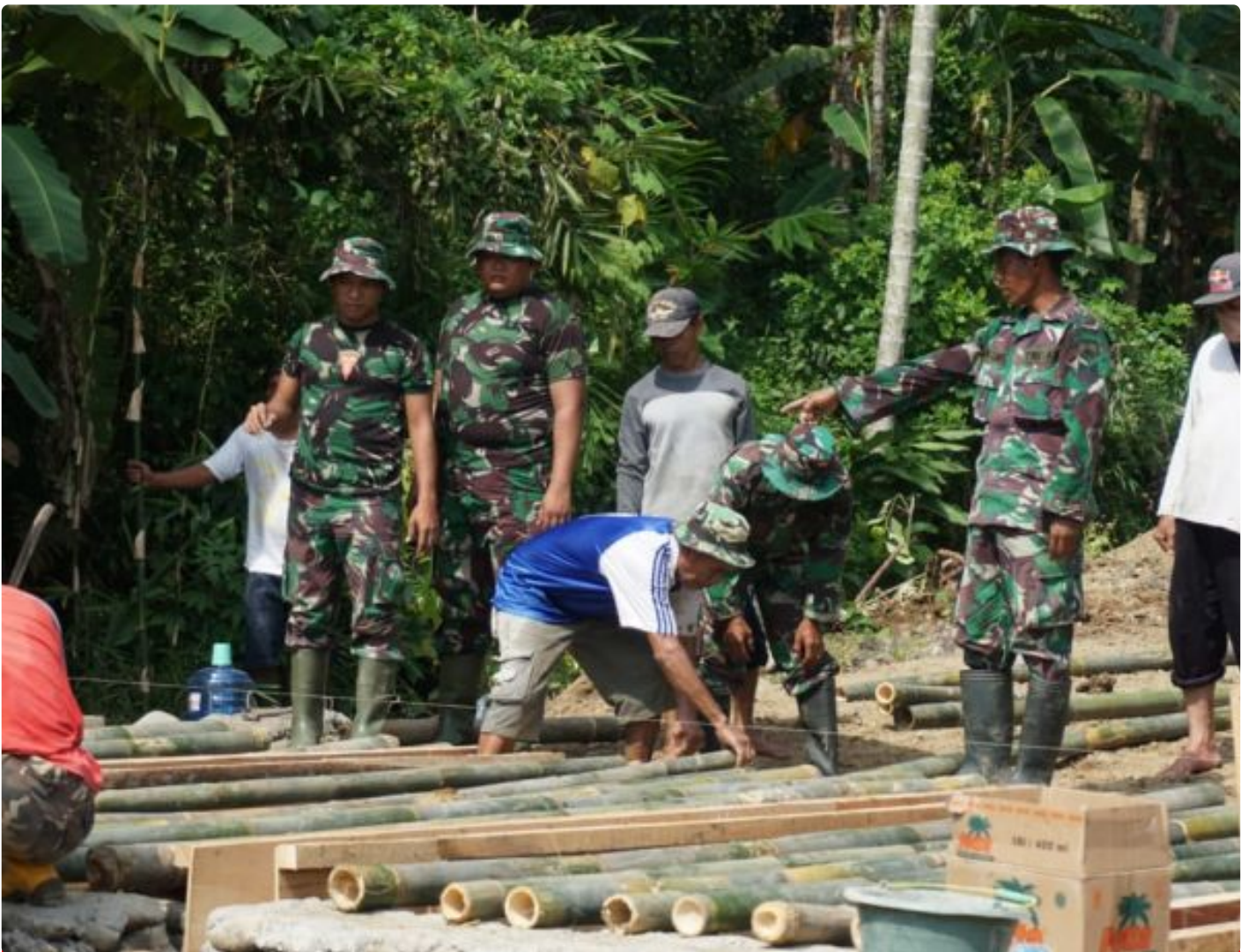
Anggota dan warga percepat Pembangunan gorong-gorong
