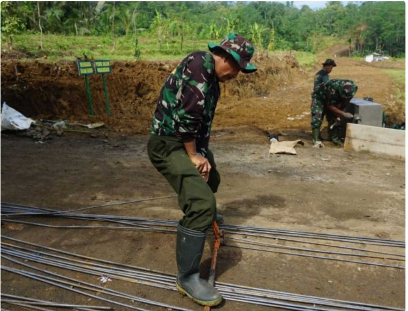
Anggota Satgas sedang membuat rangka besi cor
