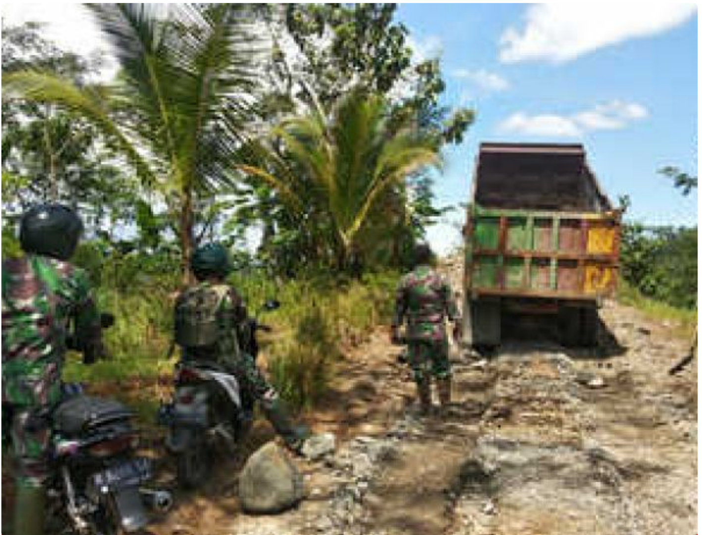
Satgas TMMD gelar material pemadatan Jalan
