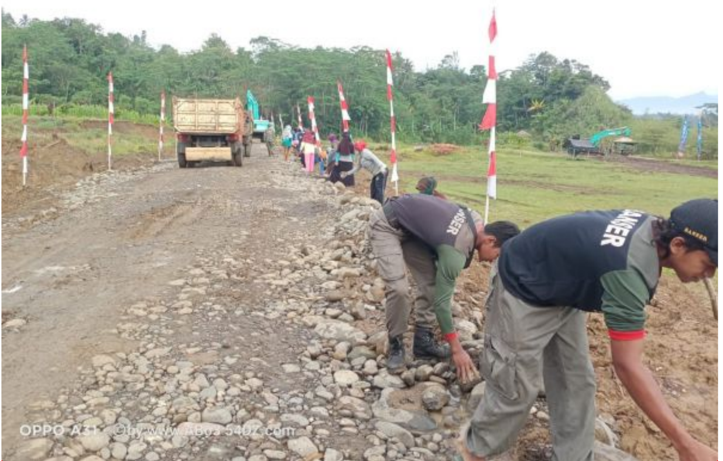
Satgas gelar material pemadatan jalan
