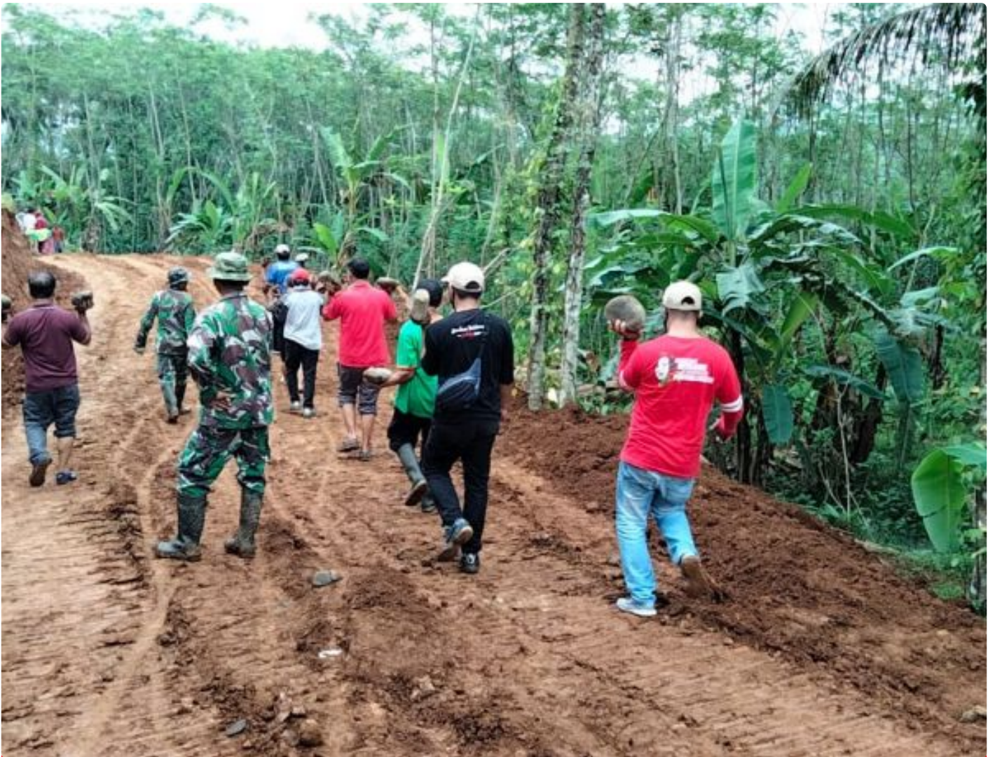
Anggota Satgas dan warga membawa batu ke sasaran pembangunan jalan
