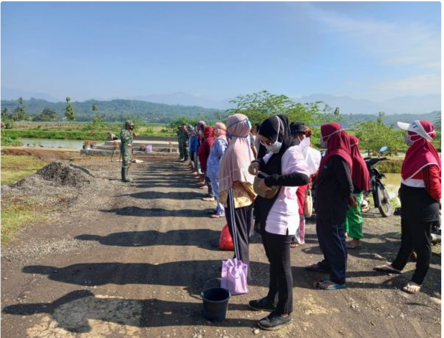
Apel pagi sebelum berkerja di TMMD pembuatn jalan
