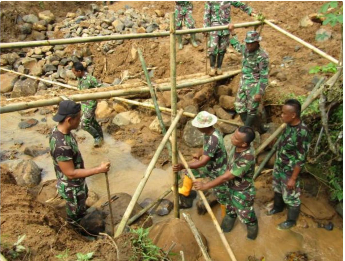
*Anggota Satgas Pasang bambu untuk plat cor beton*
