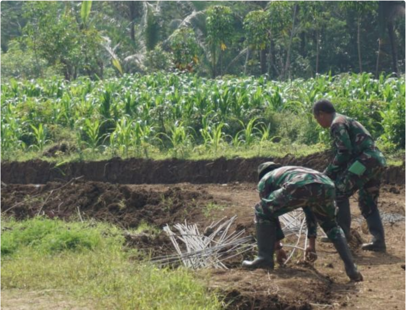
Anggota Satgas kumpulkan Besi Beton
