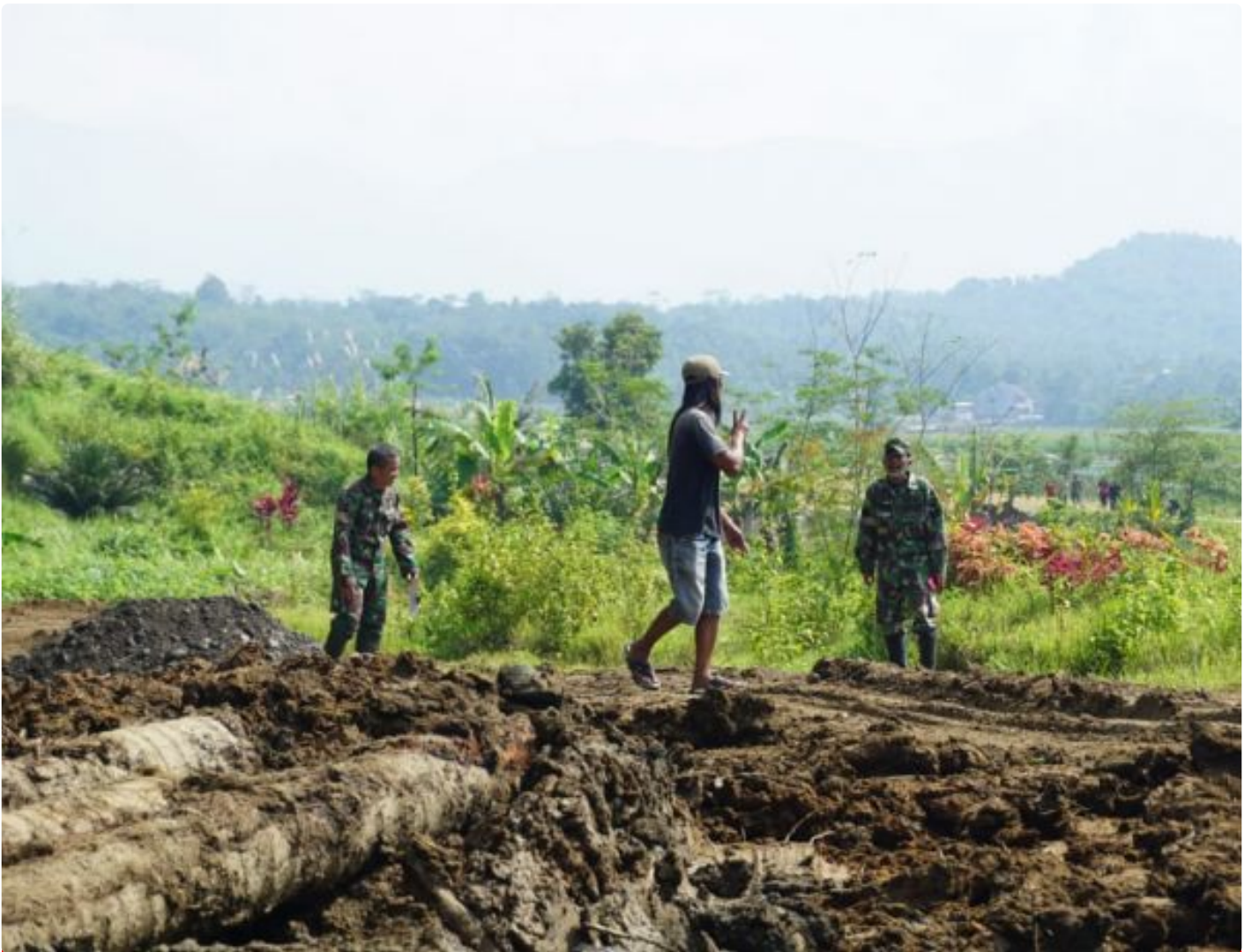
Bercanda Anggota Satgas TMMD di lokasi pembangunan jalan
