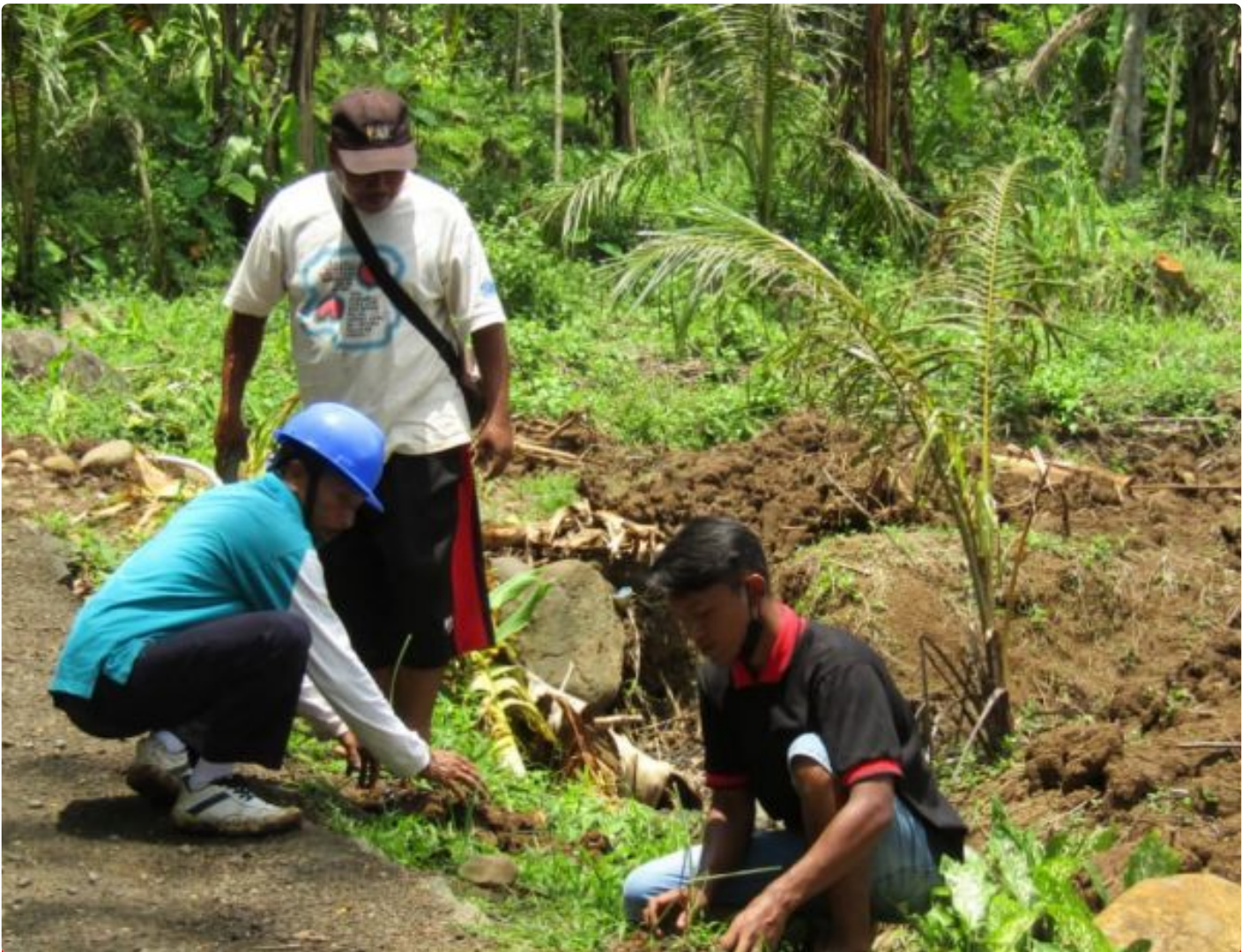
Satgas dan warga tanam vetiver cegah tanah longsor
