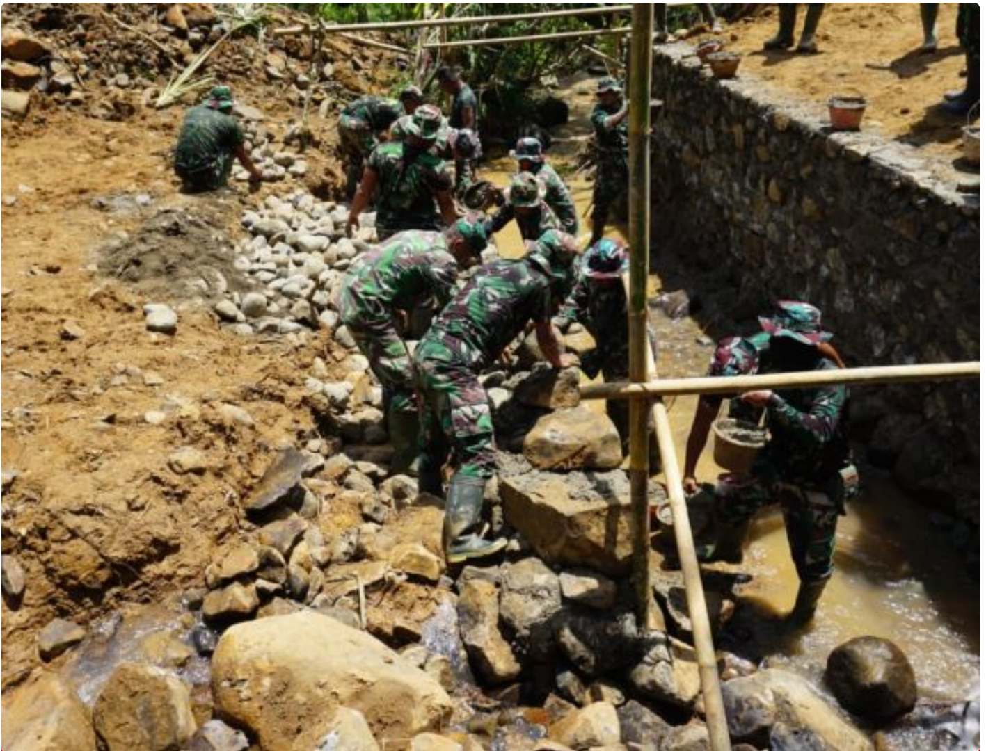
Satgas kebut pembangunan gorong-gorong
