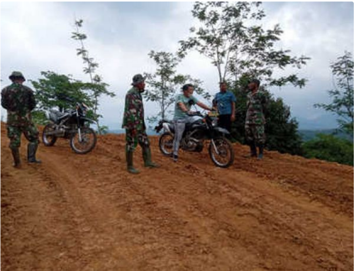
Sore hari Dan Satgas tinjau jalan baru TMMD
