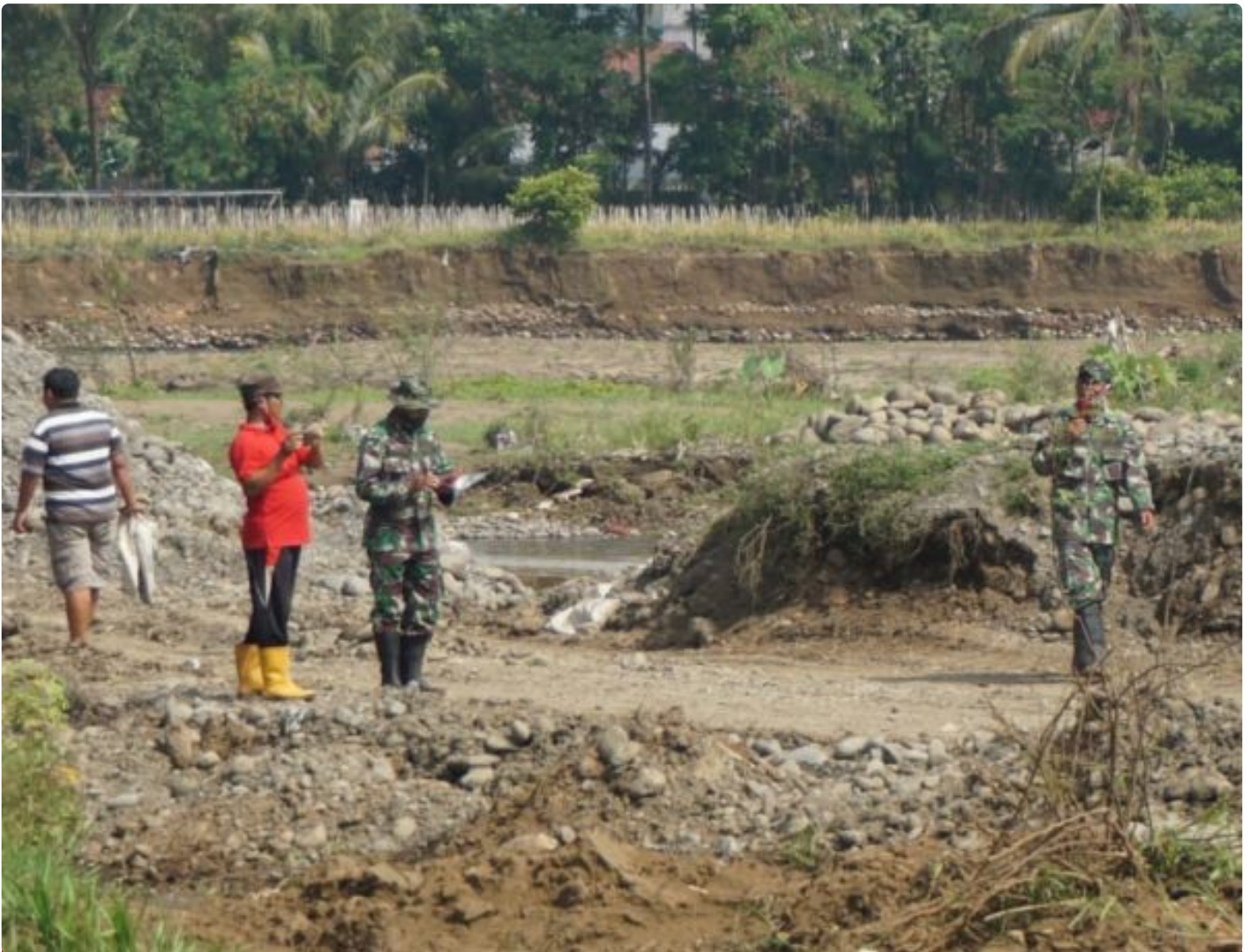
Dan SSK TMMD cek material untuk pembangunan jalan baru
