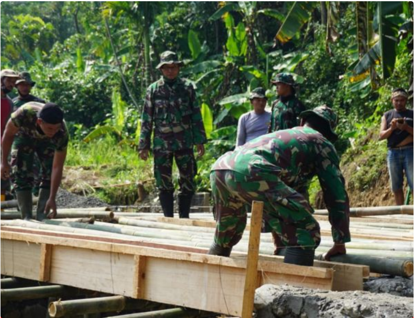
Dan SSK TMMD tinjau langsung pembangunan plat beton gorong-gorong
