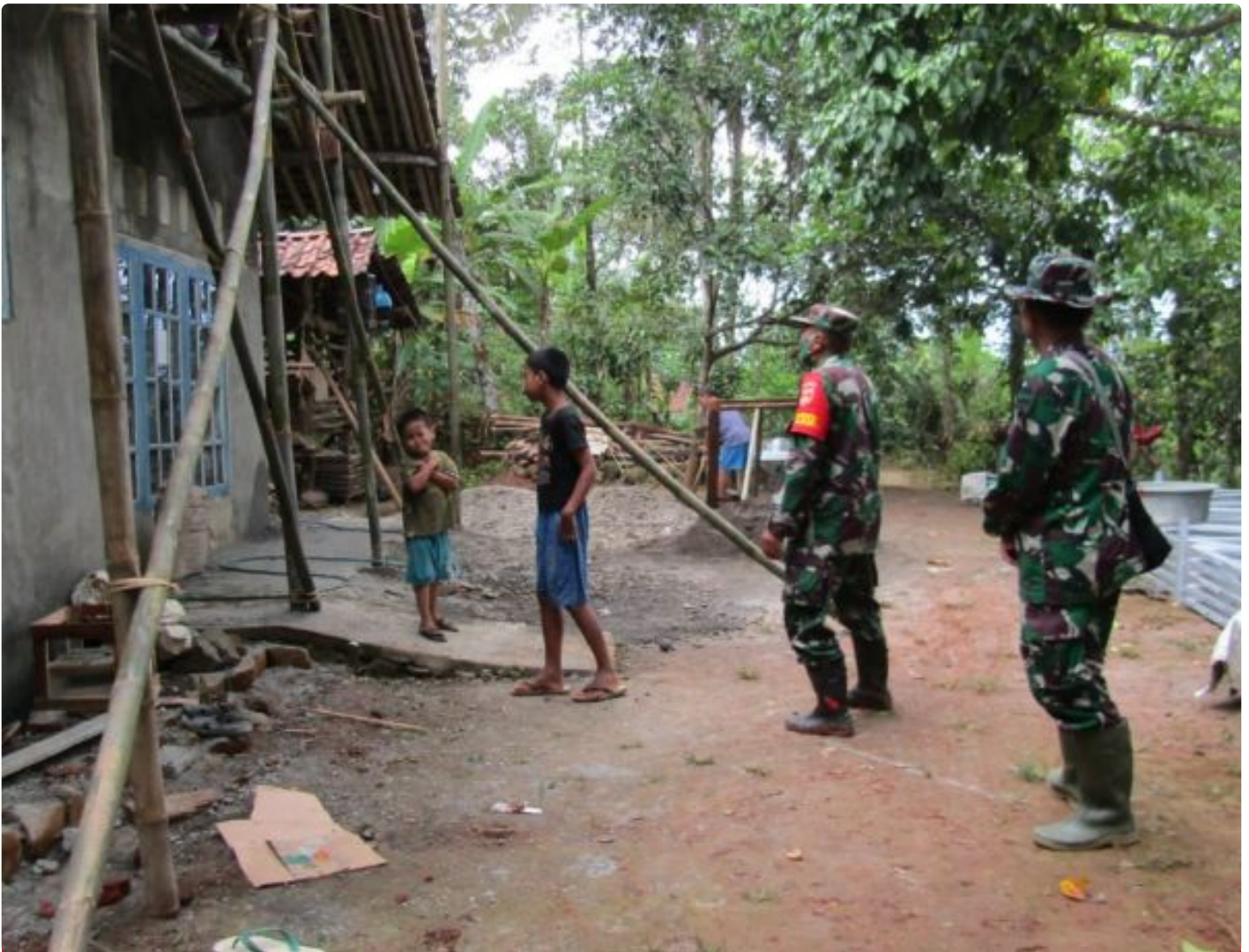
Dan SSK TMMD tinjau rehab RTLH
