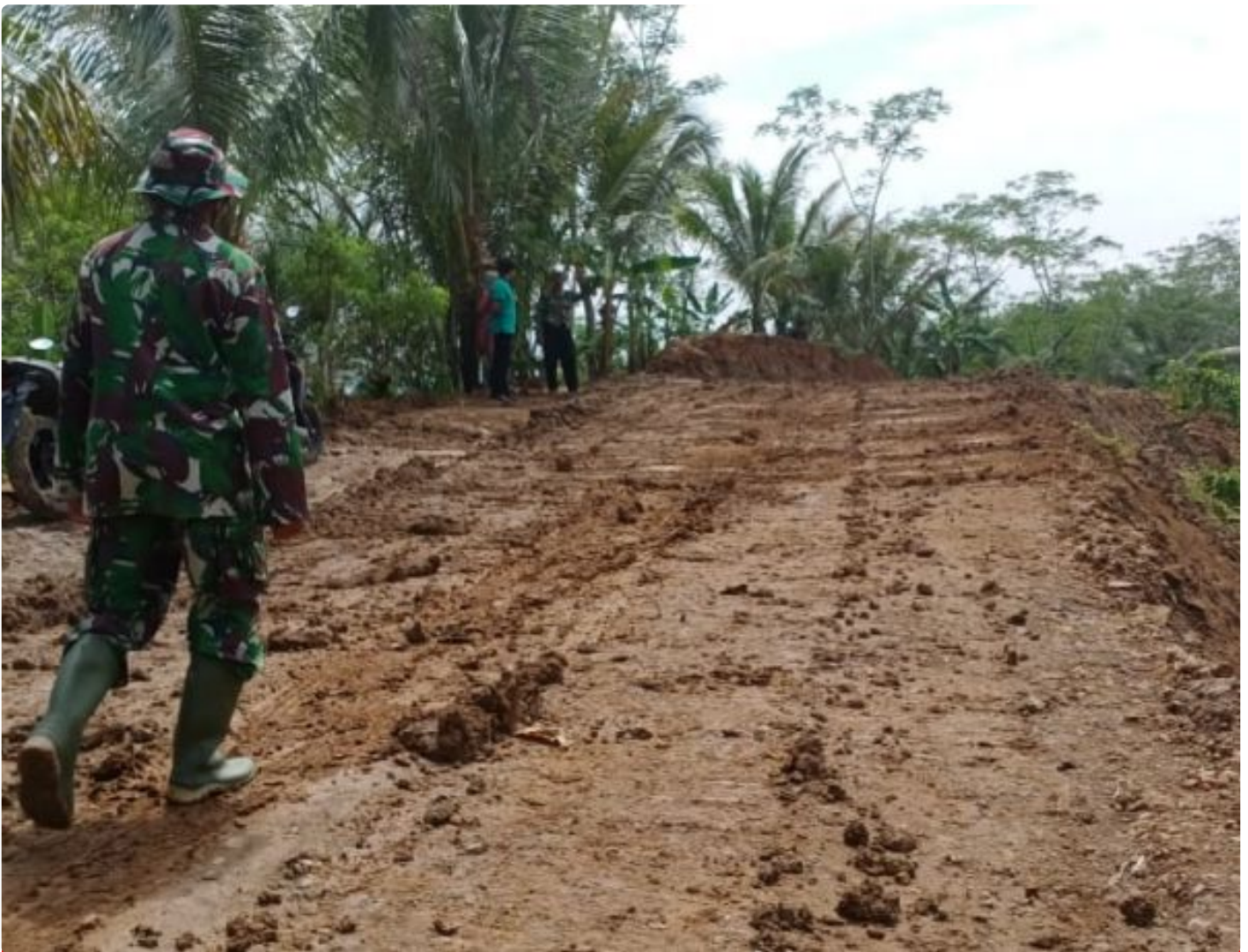
Dan SSK pantau pembangunan jalan
