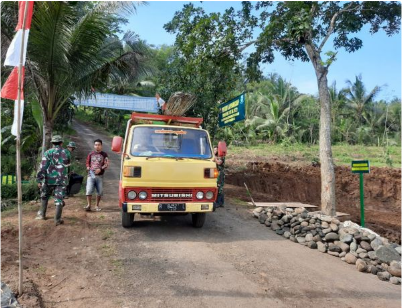
Material sudah tiba dilokasi TMMD
