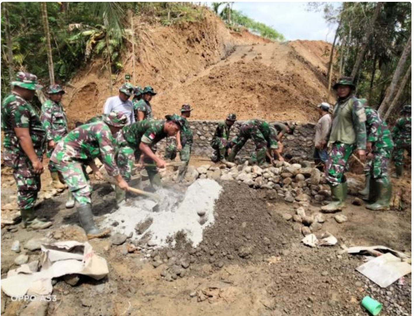
Anggota Satgas dan warga aduk material untuk cor plat beton
