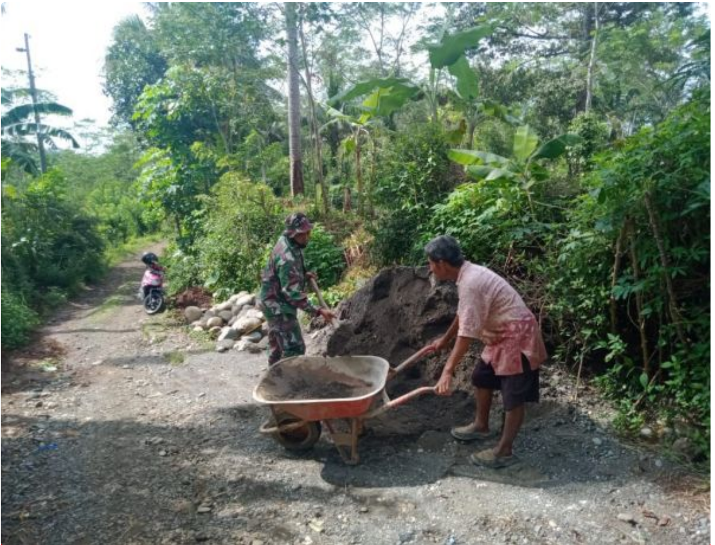
Troli alat untuk bantu langsir material TMMD
