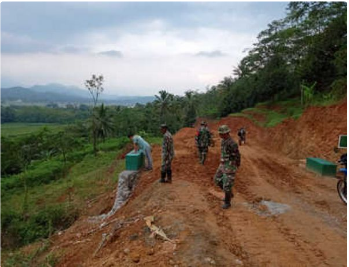
Dan Satgas pantau pembangunan jalan baru
