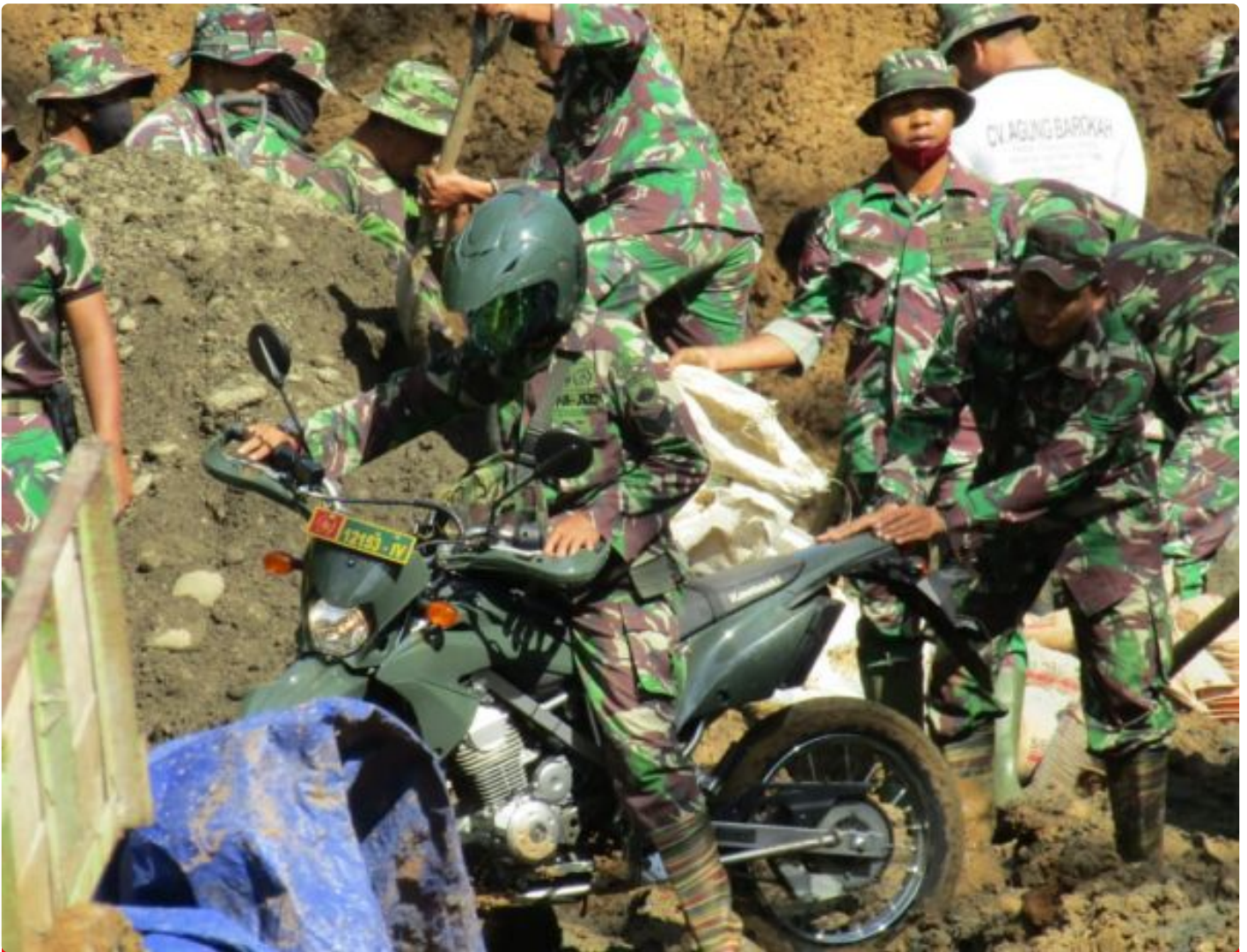
Satgas bawa material lewati jalan yang terjal dan licin
