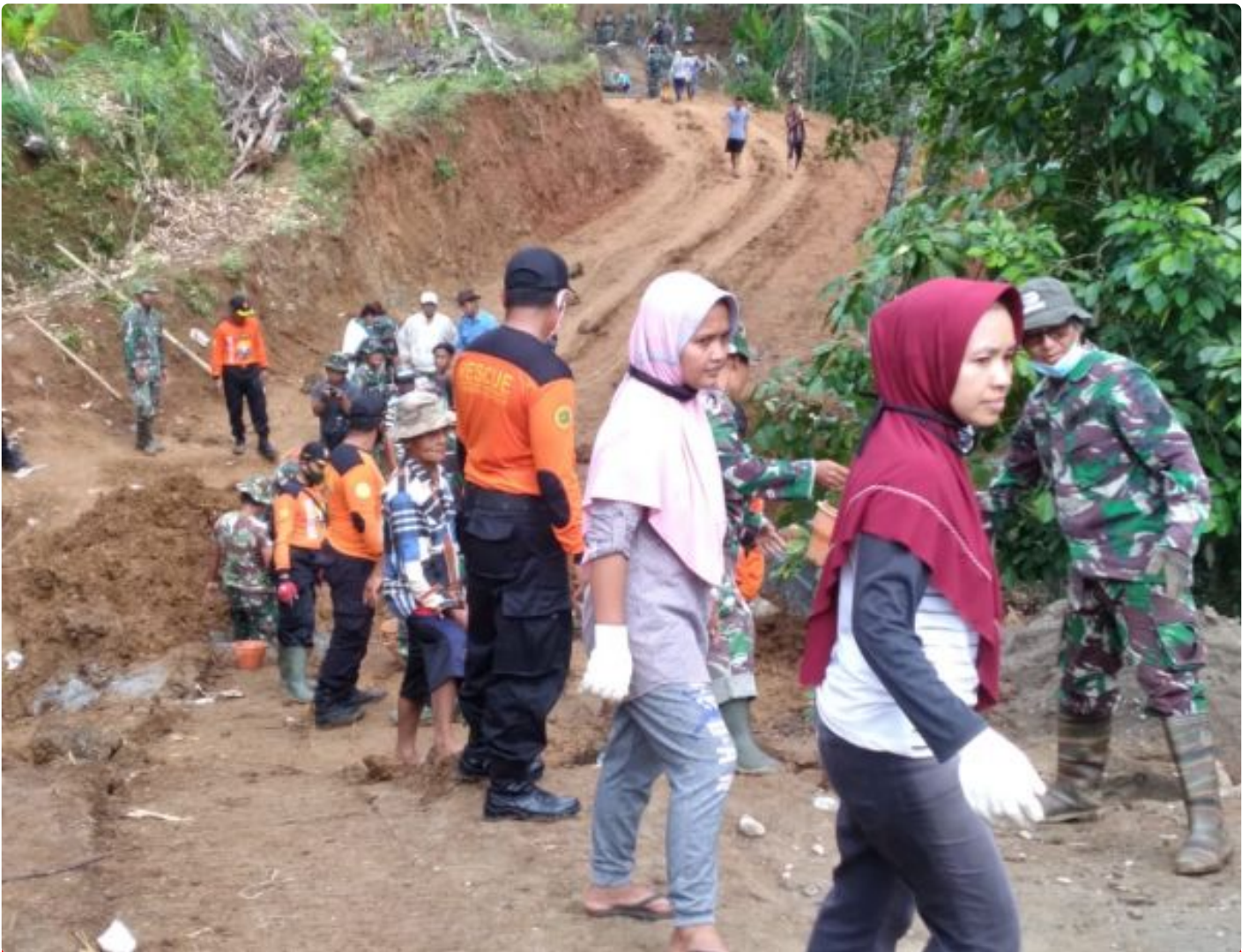
Kompak Anggota Satgas dan warga langsir material pembangunan jalan
