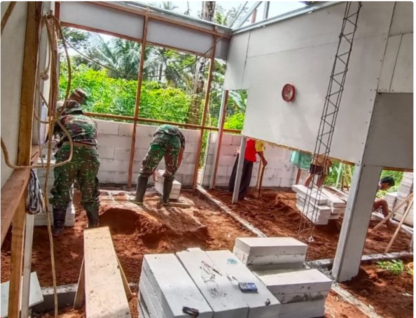
Anggota Satgas sedang memasang herbel untuk dinding RTLH
