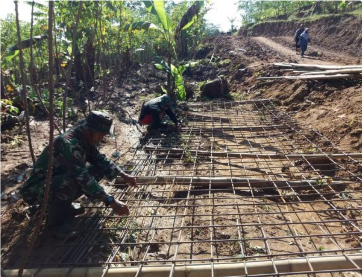
Anggota Satgas merakit kerangka plat beton
