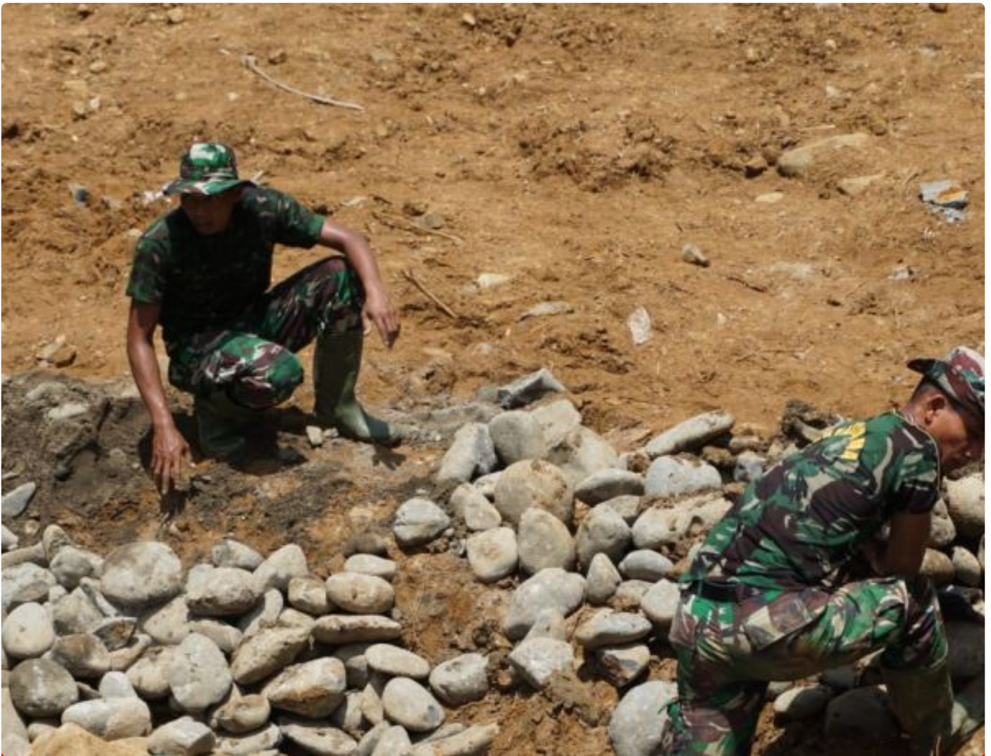
Satgas TMMD menata batu untuk pemadatan jalan
