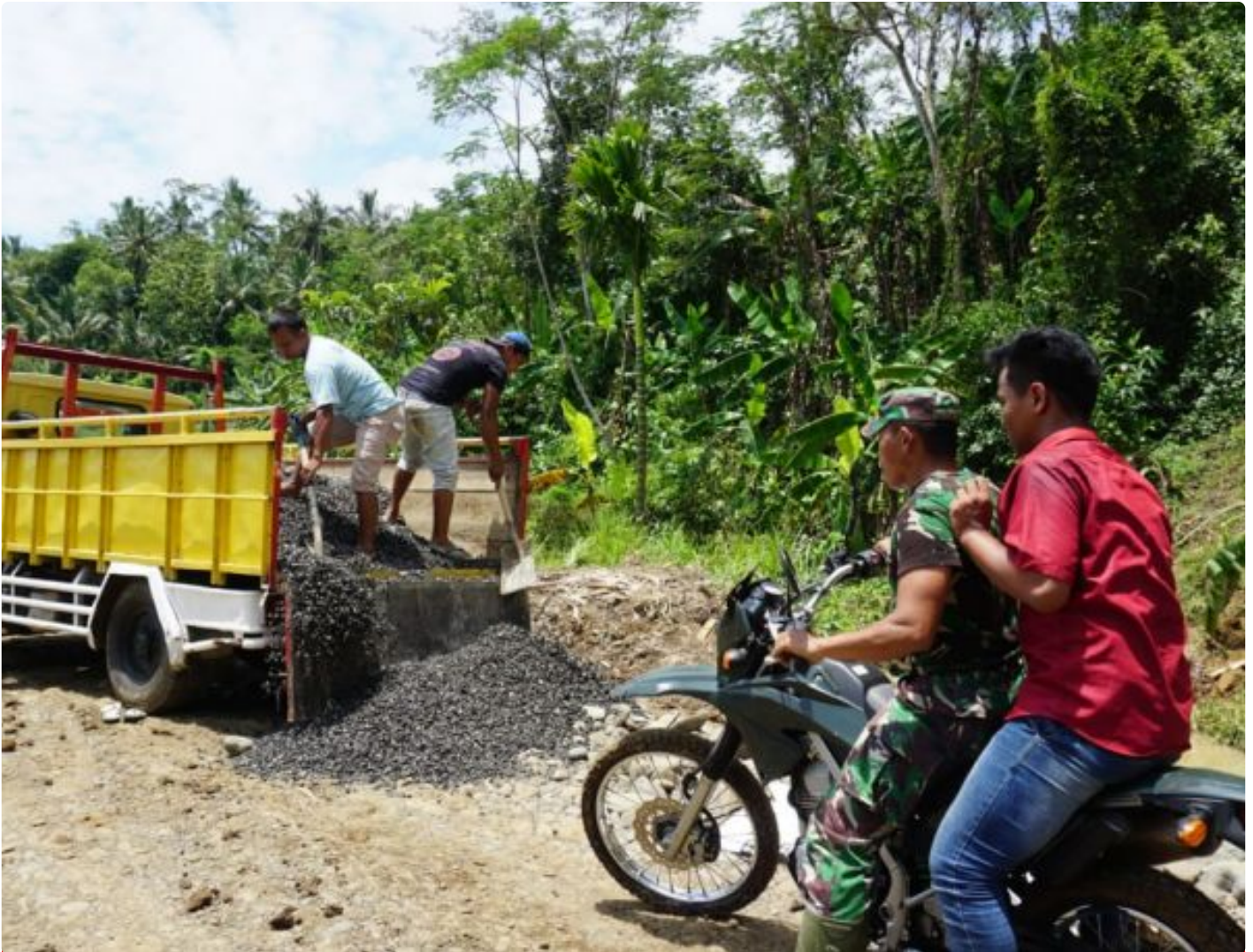
Anggota Satgas cek material pembangunan jalan
