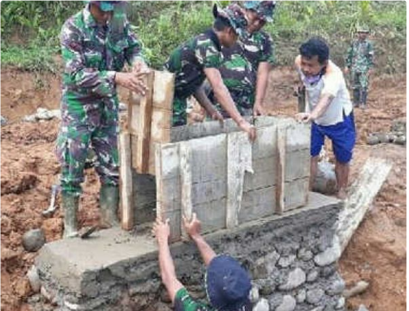
Satgas pasang plat beton gorong-gorong
