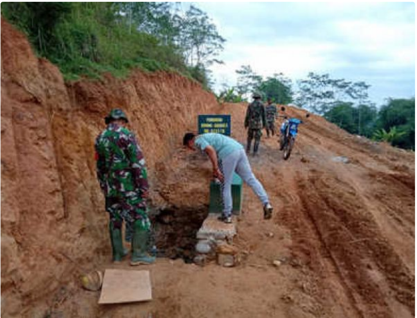
Dan Satgas cek gorong-gorong jalan baru
