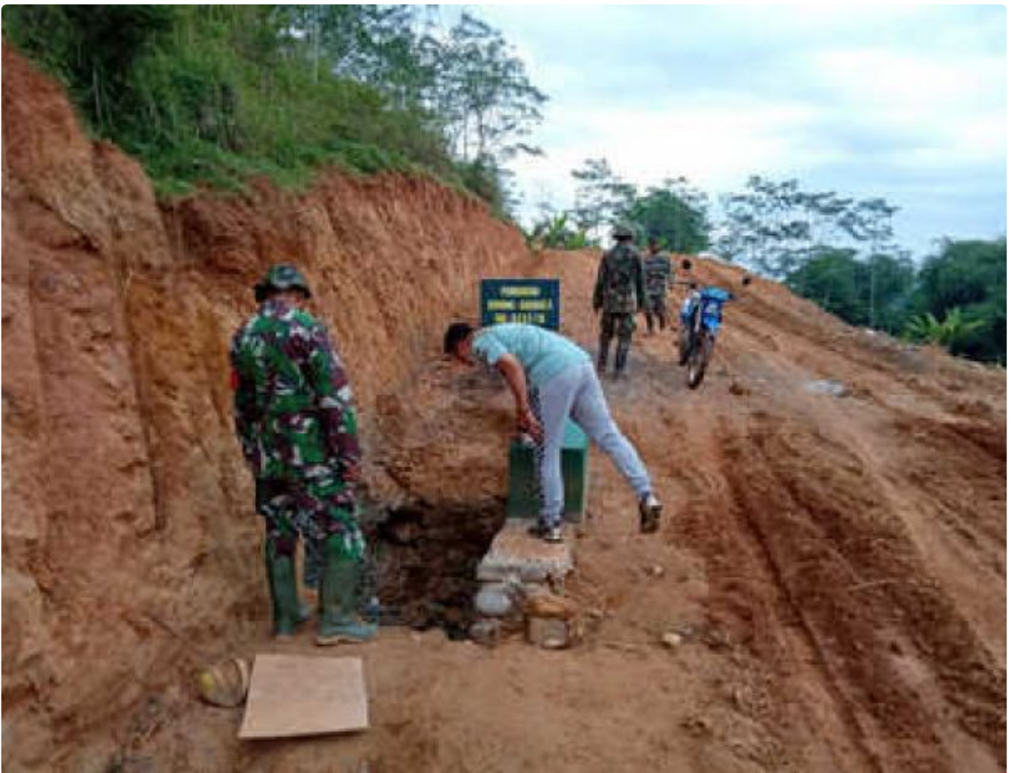
Dan Satgas cek gorong-gorong jalan baru
