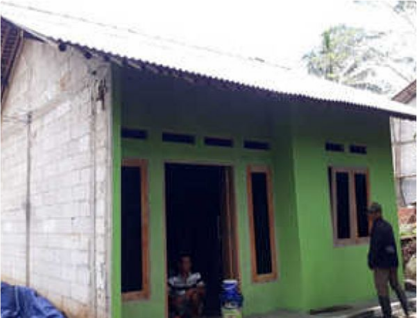
Satgas mulai pengecatan RTLH
