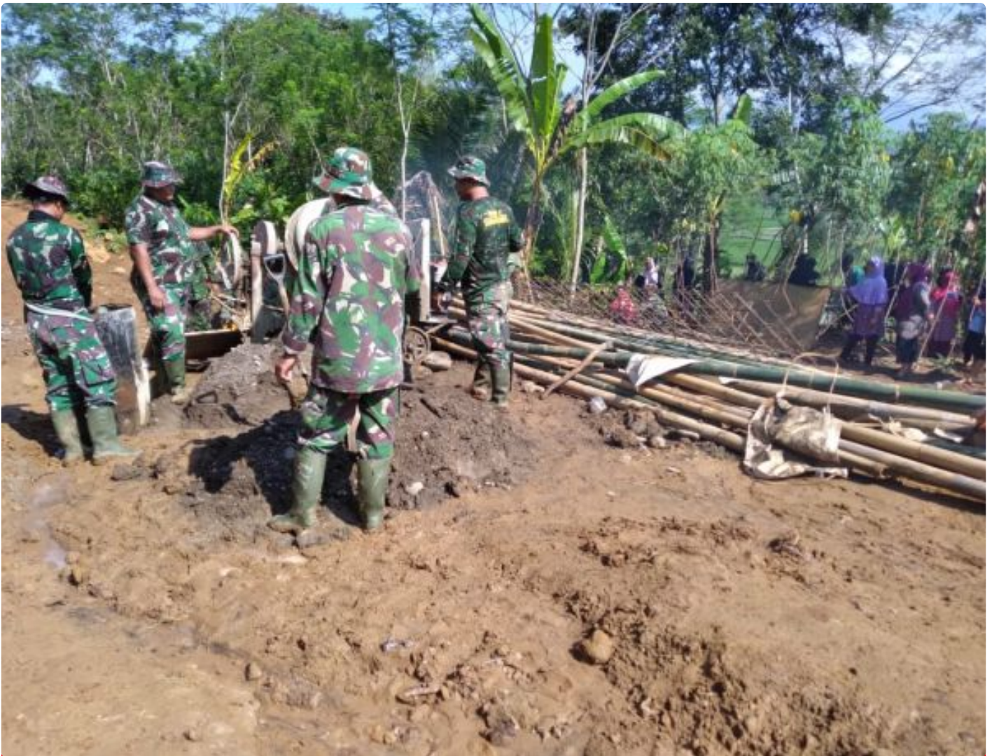
Satgas aduk material pengecoran plat beton
