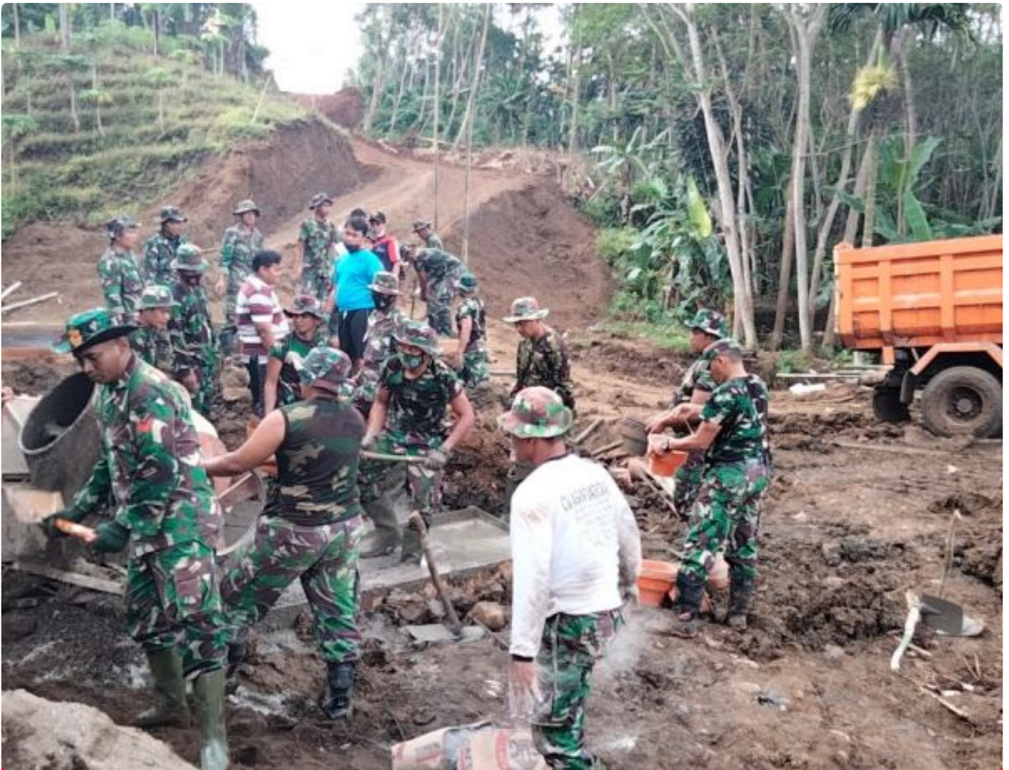
Warga ikut dalam pembangunan fisik TMMD
