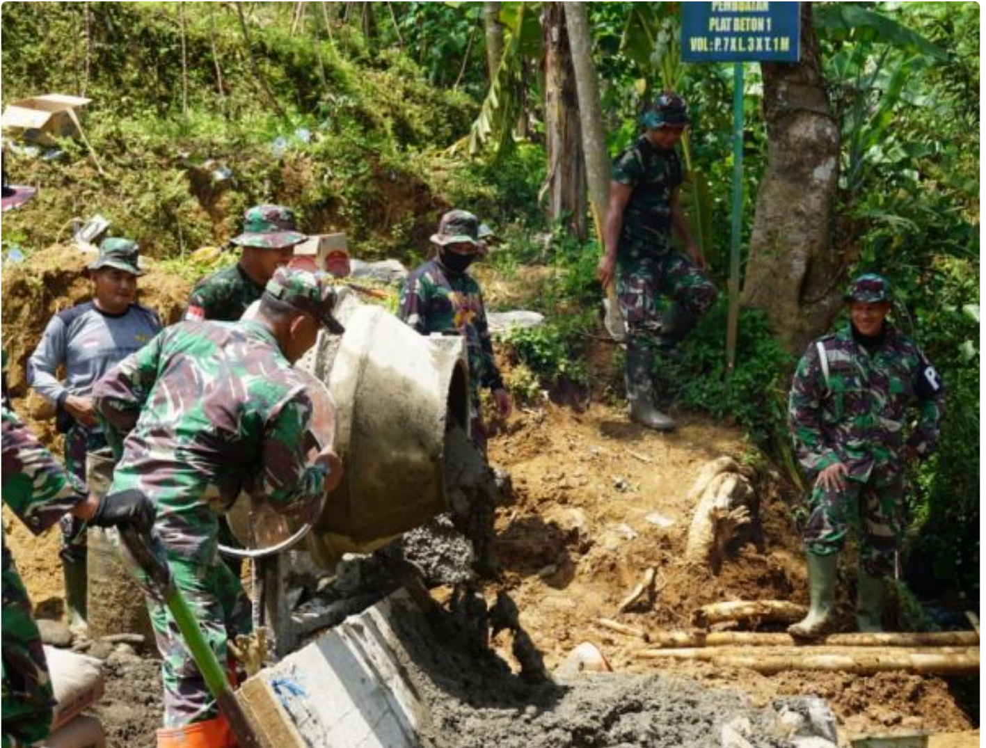
Anggota Satgas menggunakan molen untuk mempercepat adukan material
