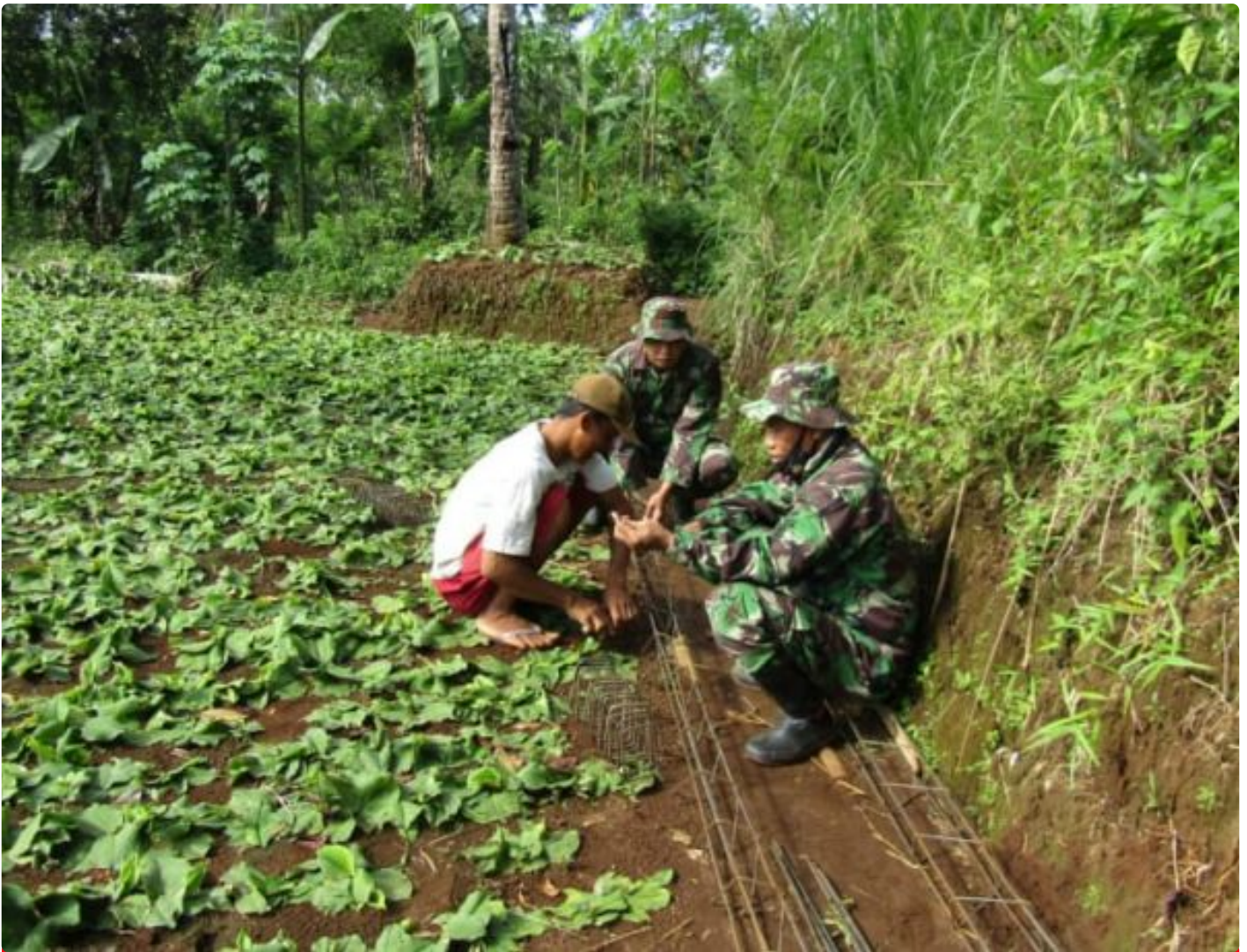
Anggota Satgas Rangkai besi untuk cor tiang bangunan RTLH
