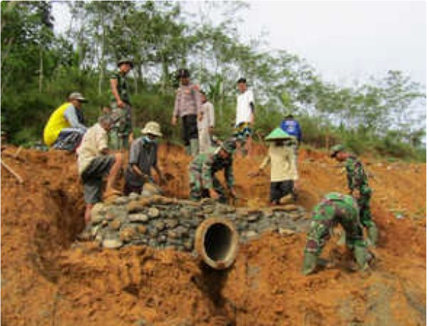
Satgas TMMD cek kelayakan pembuatan gorong-gorong
