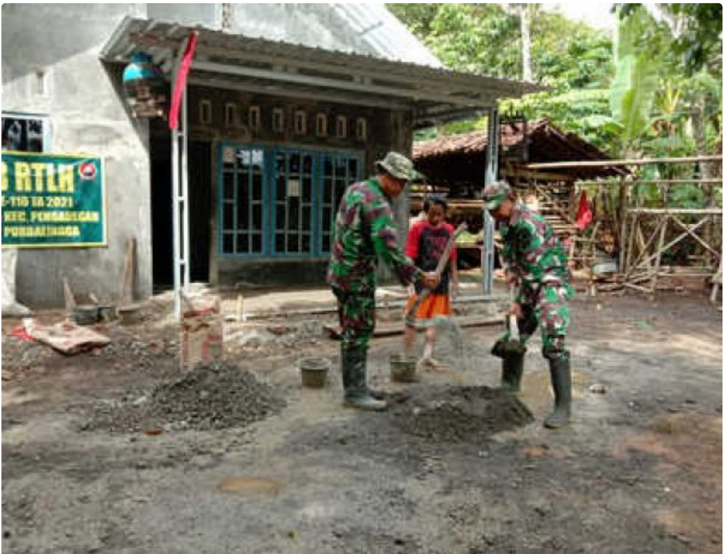
Satgas aduk material untuk plester lantai RTLH
