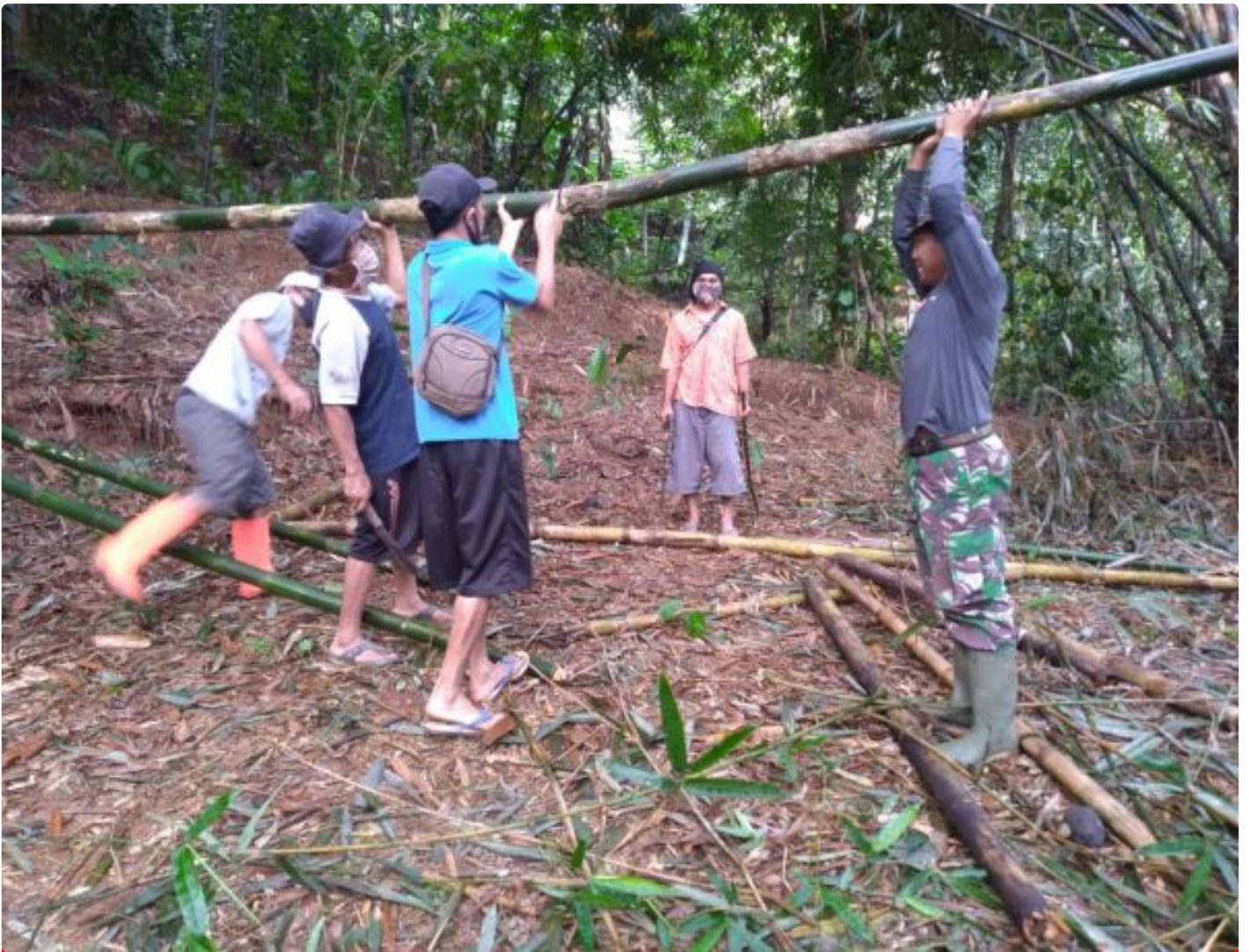
Satgas dan warga potong bambu untuk memenuhi material pembangunan jalan
