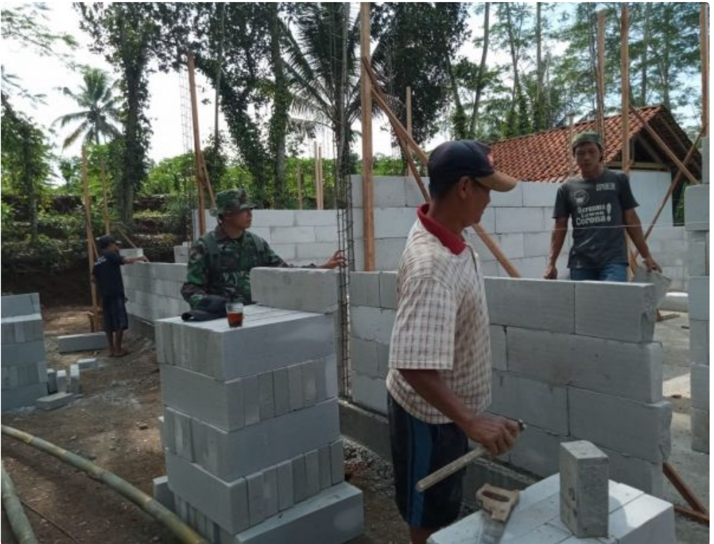
Anggota Satgas dan warga pasang herbel bangunan RTLH
