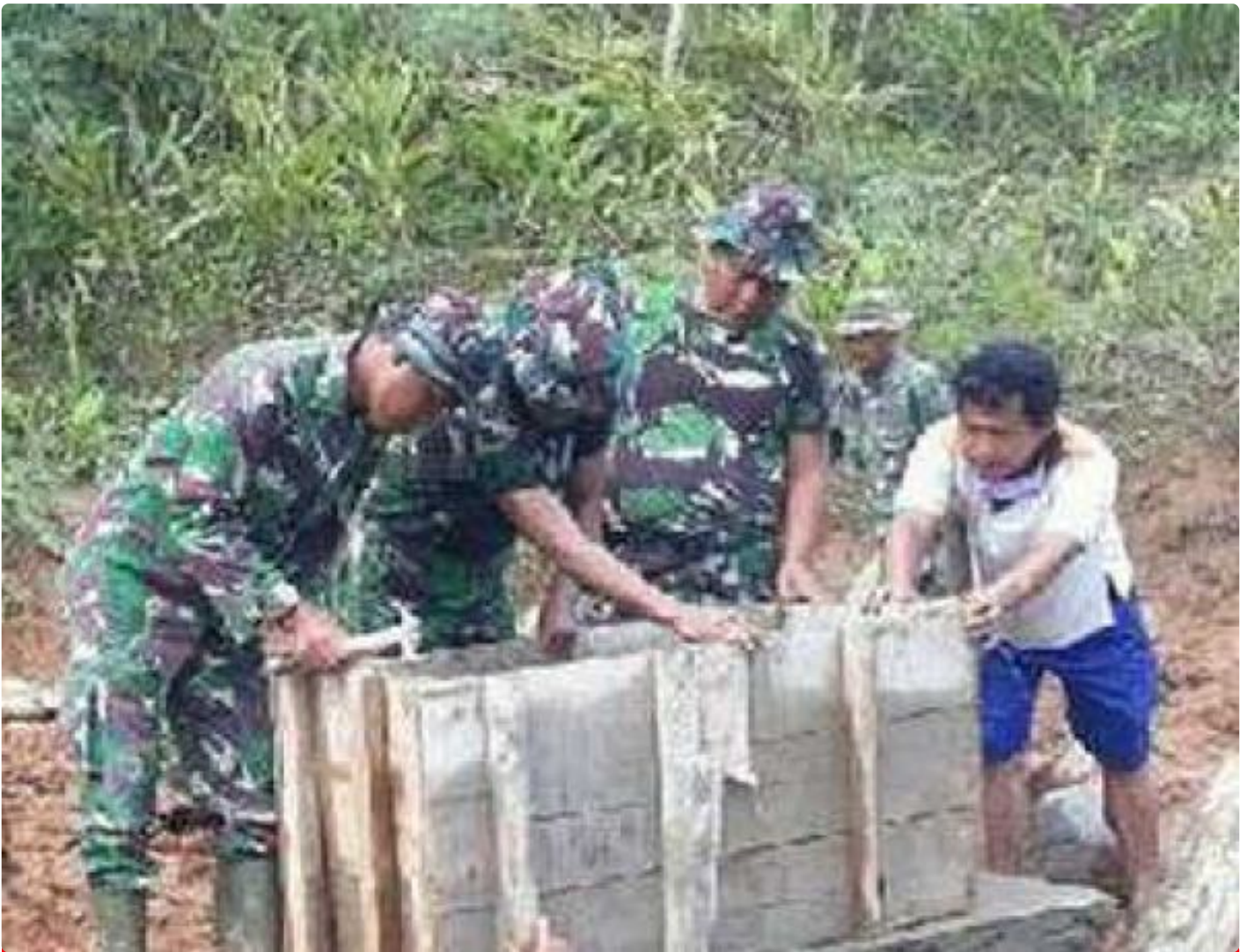
Satgas memasang Plat cor beton
