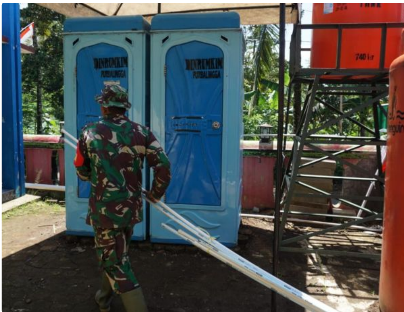
Anggota Satgas memperbaiki saluran air di Posko TMMD
