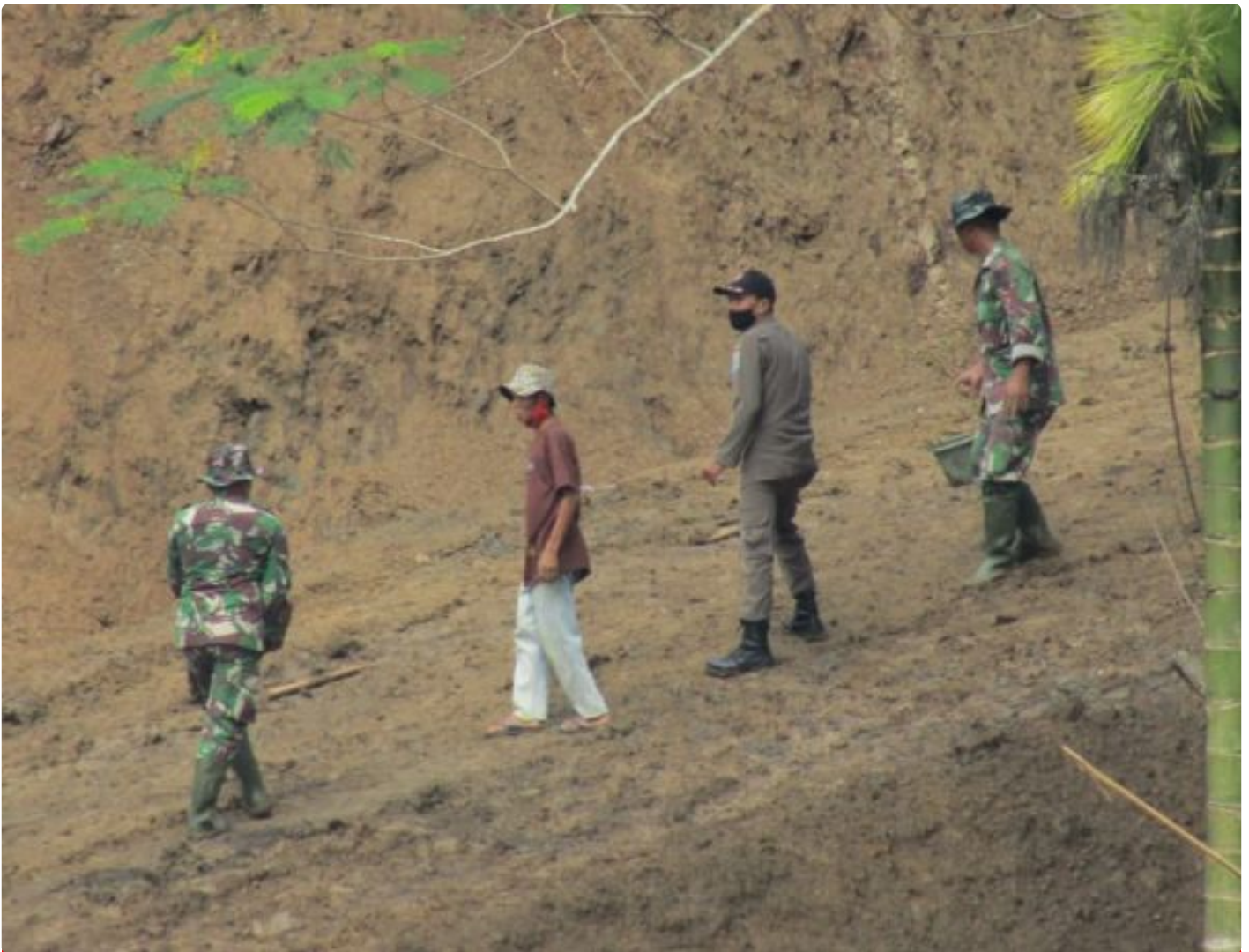
Anggota dan warga estafet material pembangunan jalan
