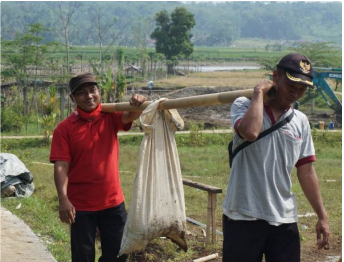
Sekdes Tumanggal Ikut Ambil Pasir untuk Pembangunan Jalan
