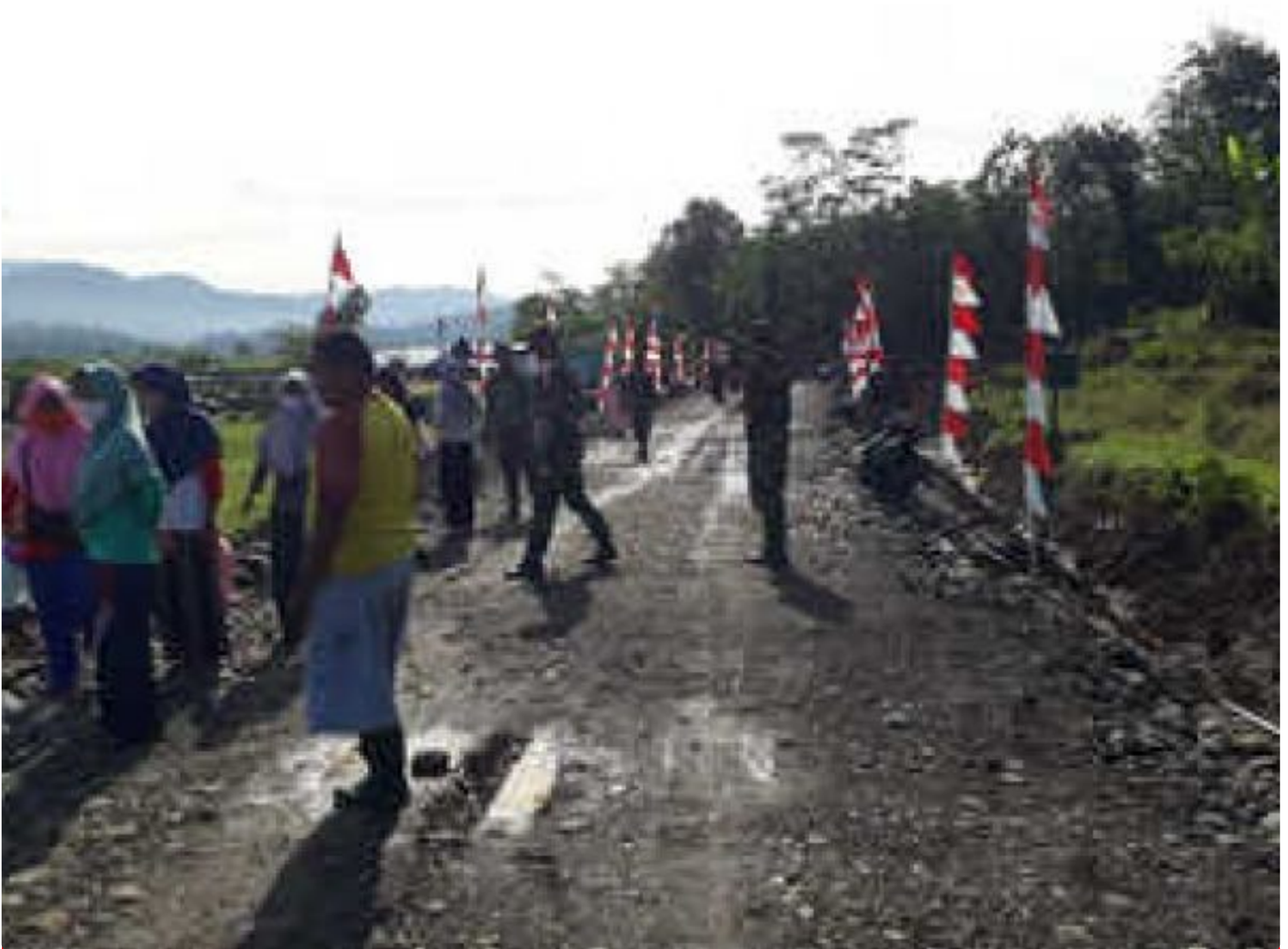
Warga dan Satgas selesaikan jalan makadam
