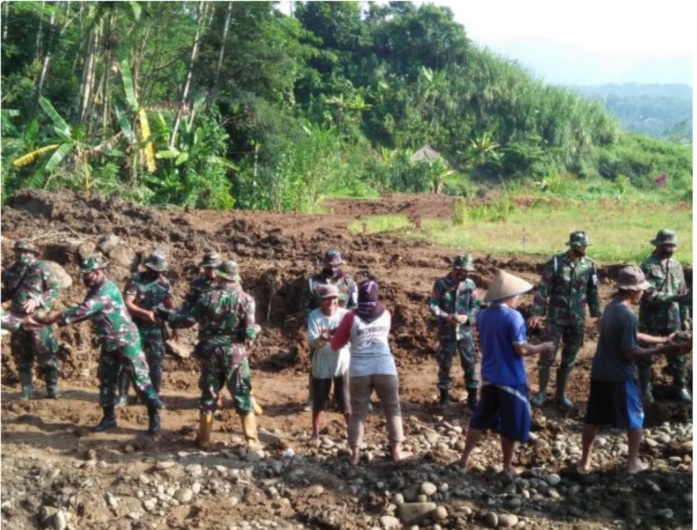
Sistem Estafet angkat batu di lokasi TMMD
