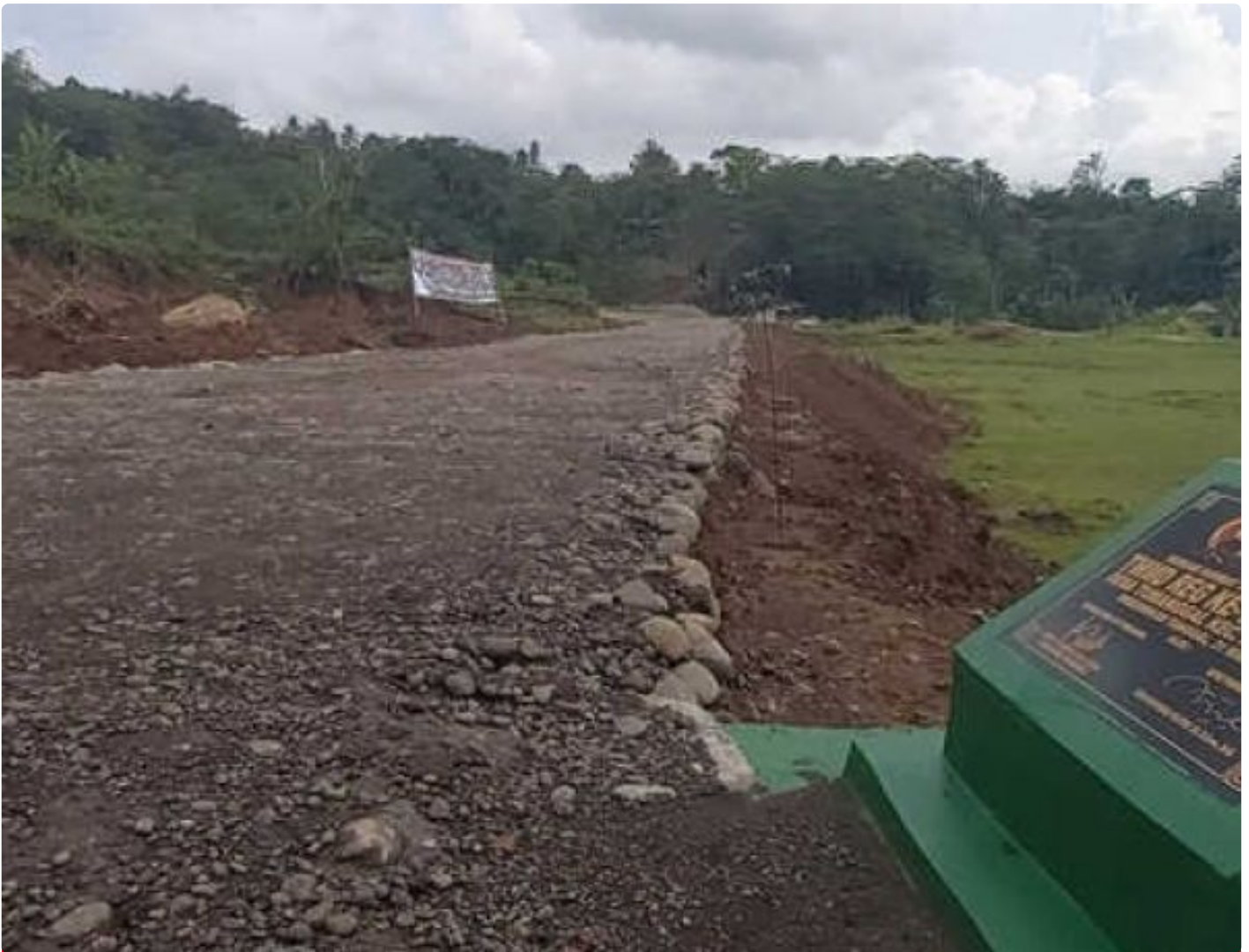
Jalan hasil pembangunan TMMD Desa Tumanggal
