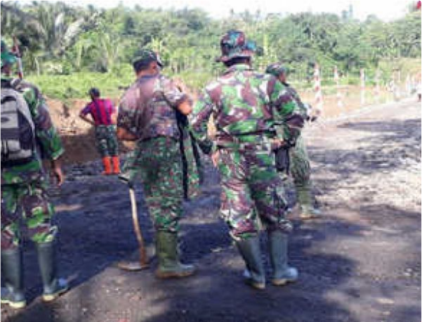
Material tertata rapi, pemadatan tahap akhir
