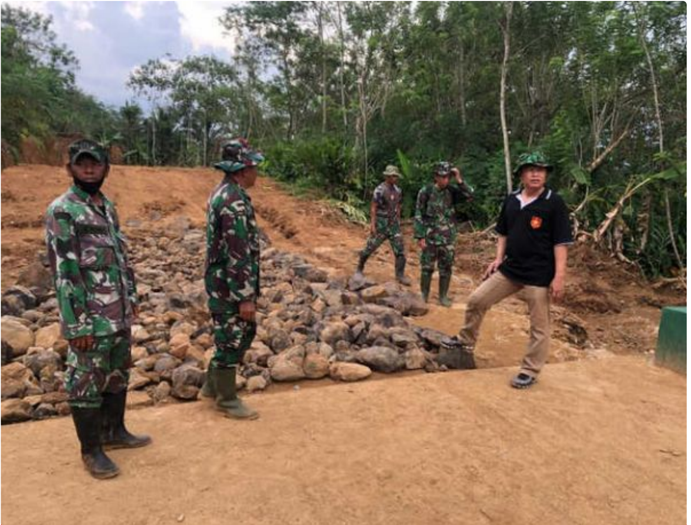
Dan Satgas tinjau pematatan jalan titik tengah
