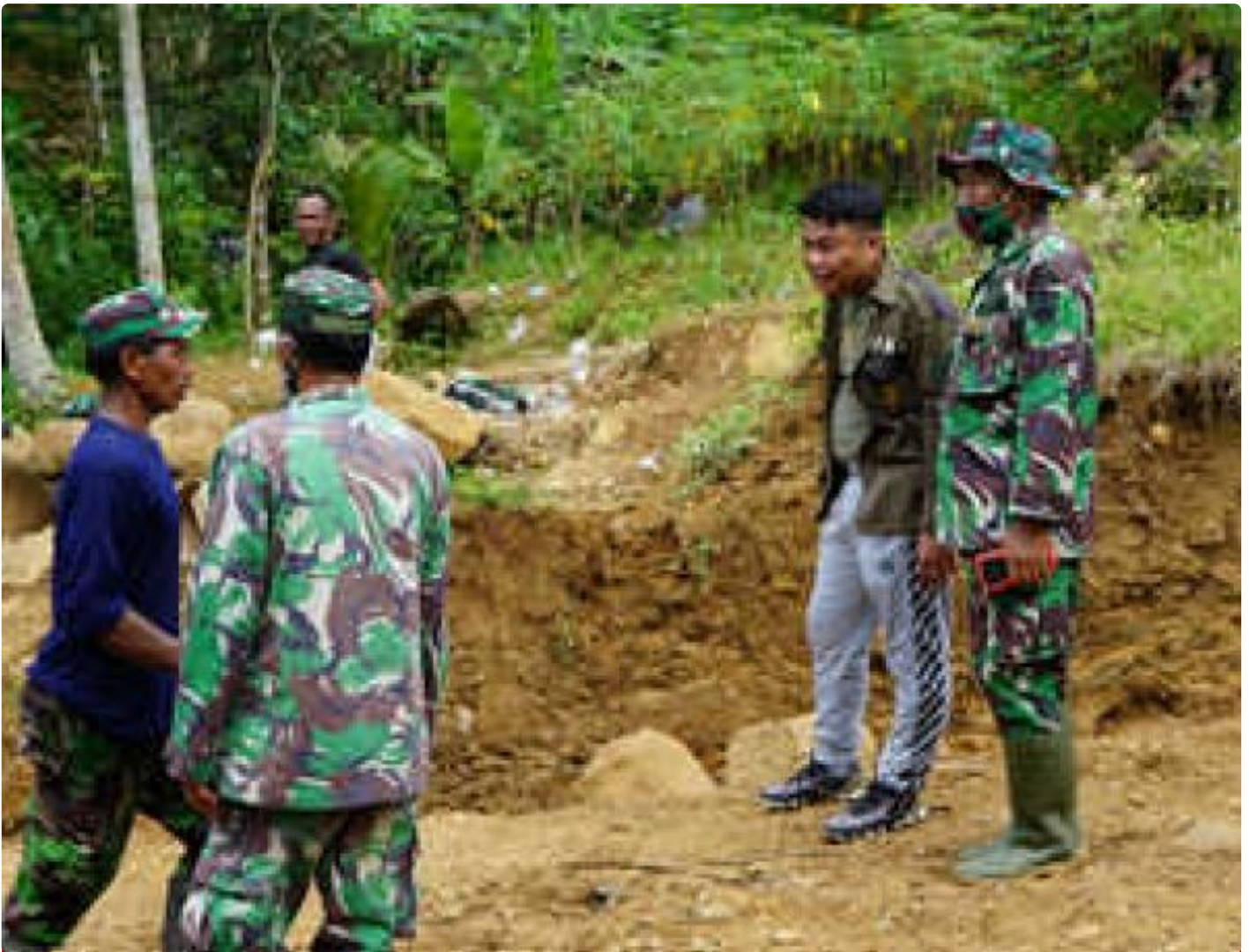
Jalan baru akses permudah warga Tumanggal
