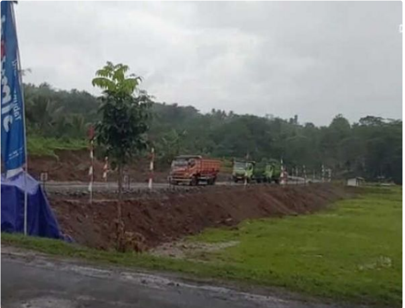
Truk sudah bisa melewati jalan baru hasil TMMD
