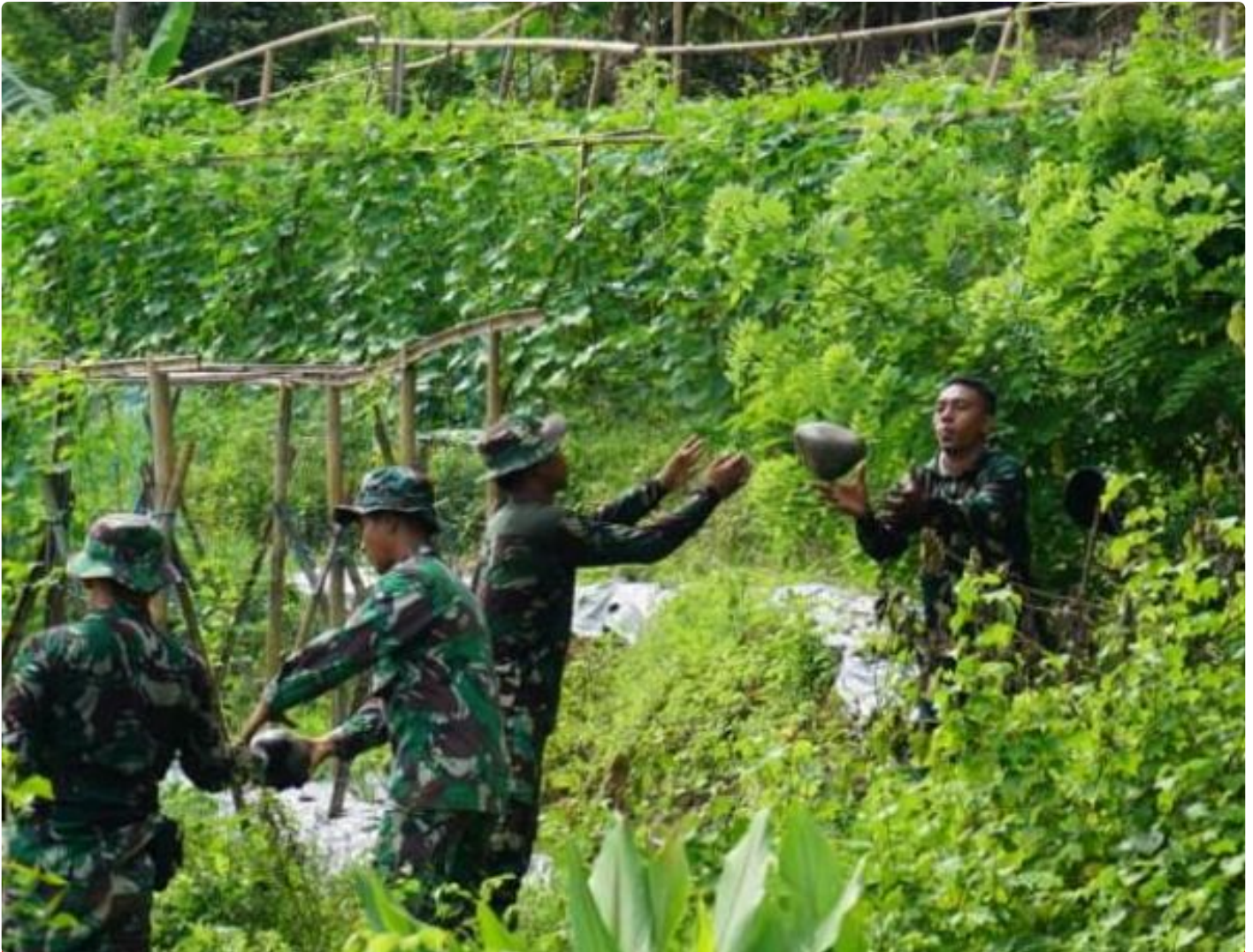
Warga Bantu Satgas slesaikan pembangunan jalan
