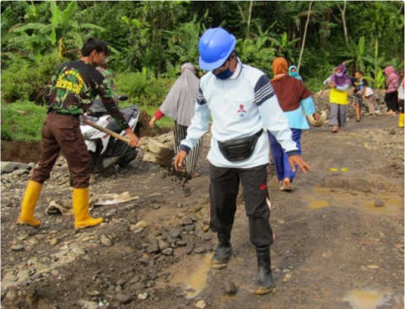
Warga gelar sirtu pemadatan jalan
